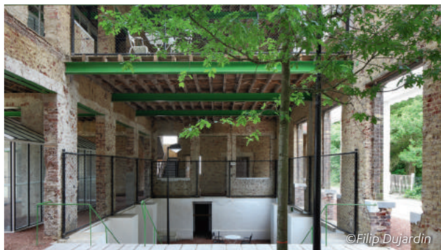
PC CARITAS w Melle zaprojektowany przez pracownię architektoniczną de vylder vinck taillieu
